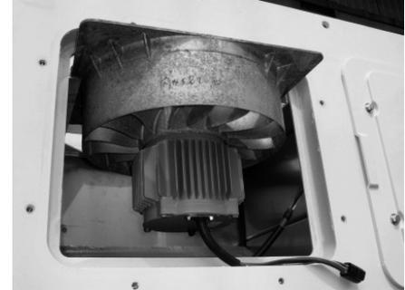
e. Remove fan mounting plate and replace fan motor.
